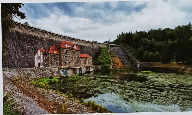
Pilchowice, hydroelektrownia na rzece Bóbr. Foto –Dreamstime
