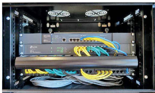
Rys. 7. Okablowanie sieciowe w szafie dystrybucyjnej.
